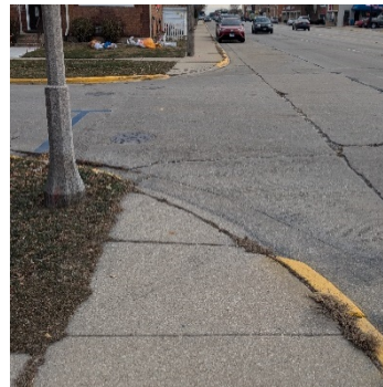
_____ No hay paneles de advertencia detectables (baches en la parte inferior de la rampa)
