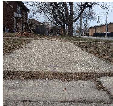
_____ No hay paneles de advertencia detectables (baches en la parte inferior de la rampa)
